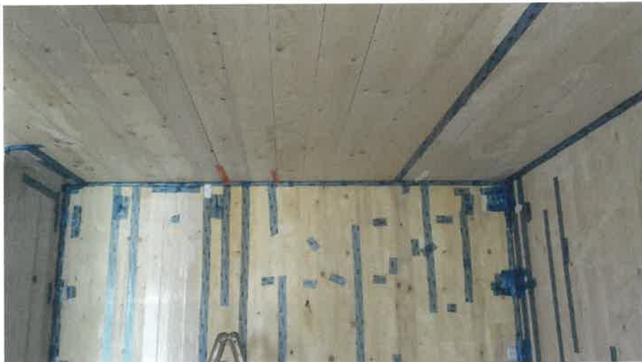
Slika 5: Uhanje zraka pri gradnji lesene masivne stavbe. Korektivni ukrep je dodatno tesnjenje stikov. Po odpravi pomanjkljivosti se ponovi meritev zrakotesnosti - vir: GI ZRMK
