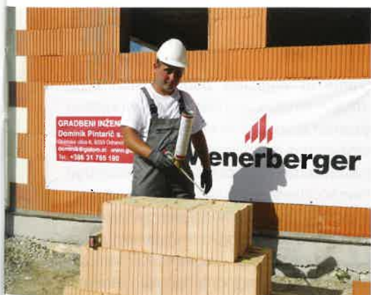
Mojster Siniša Gajič je prikazal lepljenje Porotherm IZO Profi zidakov z lepilom Porotherm Dryfix.extra.
