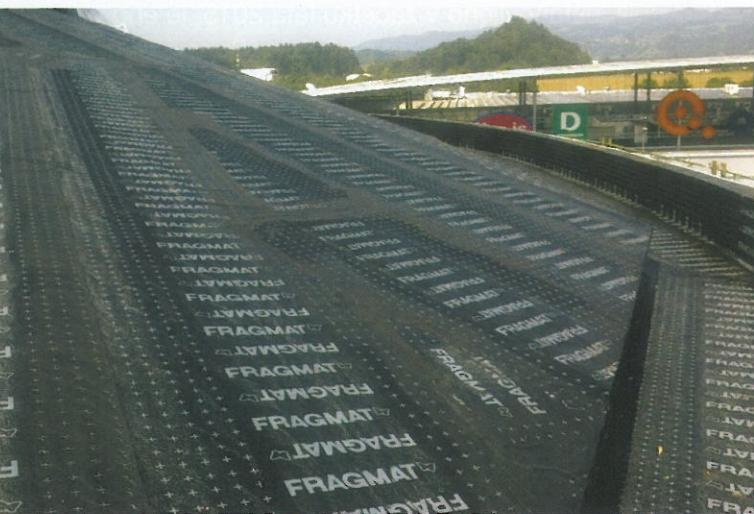
Prvi sloj topotno izolirane bitumenske strehe
