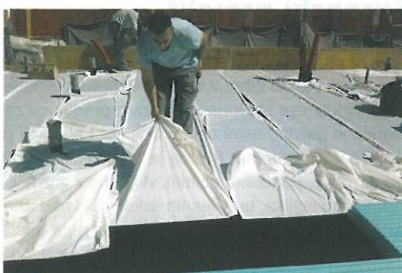
Pred nameščanjem podložnega betona in prvega sloja toplotne izolacije FIBRANxps posebno pozornost namenimo inštalacijam. Na natančno položeni prvi sloj toplotne izolacije FIBRANxps 400-L ali druge tlačne trdnosti in ustrezne debeline nalepimo samolepljivo hidroizolacijo FIBRANhydro SEISMIC T-1,8 sk/sk.
